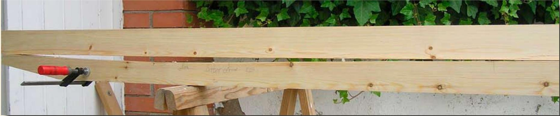
Las bordas ya perfiladas. Un listón con un canto recto colocado encima permite apreciar mejor la cantidad que se ha rebajado (quizás excesiva?) Tiempo total invertido en este paso usando herramientas exclusivamente manuales: unas 2 horas (añádase el doble de tiempo si se pretende fotografiar el proceso y registrarlo, en un blog, por ejemplo).
